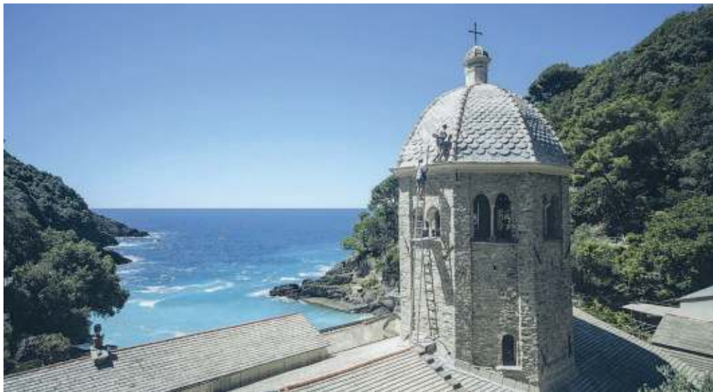
LAVORI DI MANUTENZIONE DELLA TORRE NOLARE DI CAMOGLI
